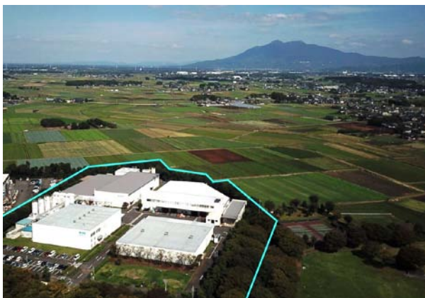
①工場全景(筑波山を望む)
