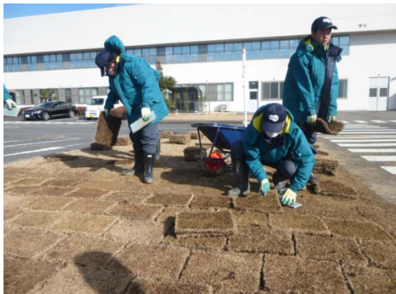
芝張り替え作業
