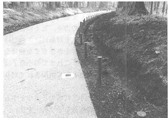
写真10 土側溝、車止めと透水性舗装
