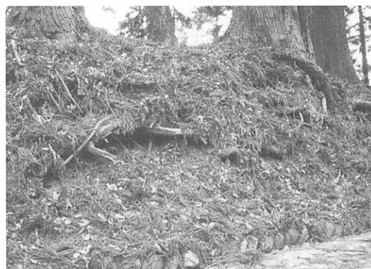
写真2 根を切られた道路法面
