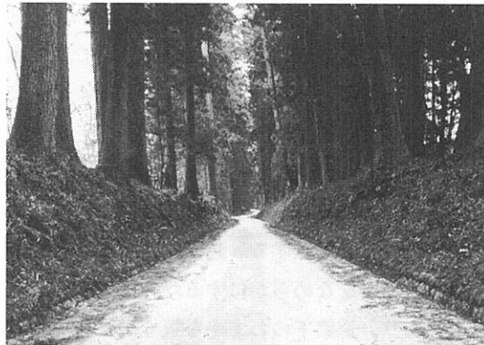
写真4 掘り下げられた路盤
