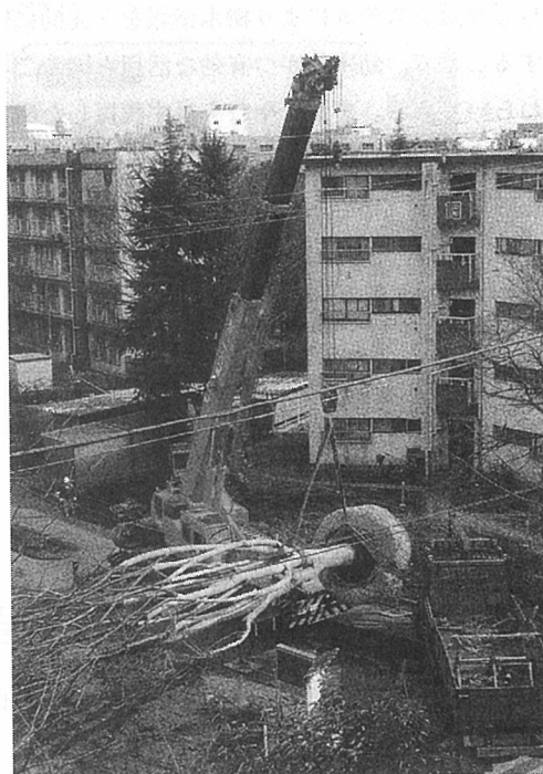
写真6 長年育って大木となったケヤキが、大きなクレーンなどにより移植されます。緑のリサイクルとして再生されているのです。(武蔵野緑町パークタウン)
