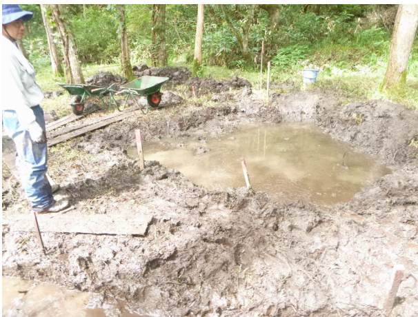
水路作りへの参加の様子（自然再生士実地研修、岡山県真庭市）
