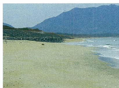
■④石積護岸建設 平成11年頃～
