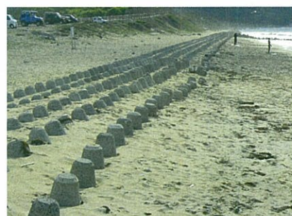
■②消波ブロック護岸建設 昭和58年頃～
